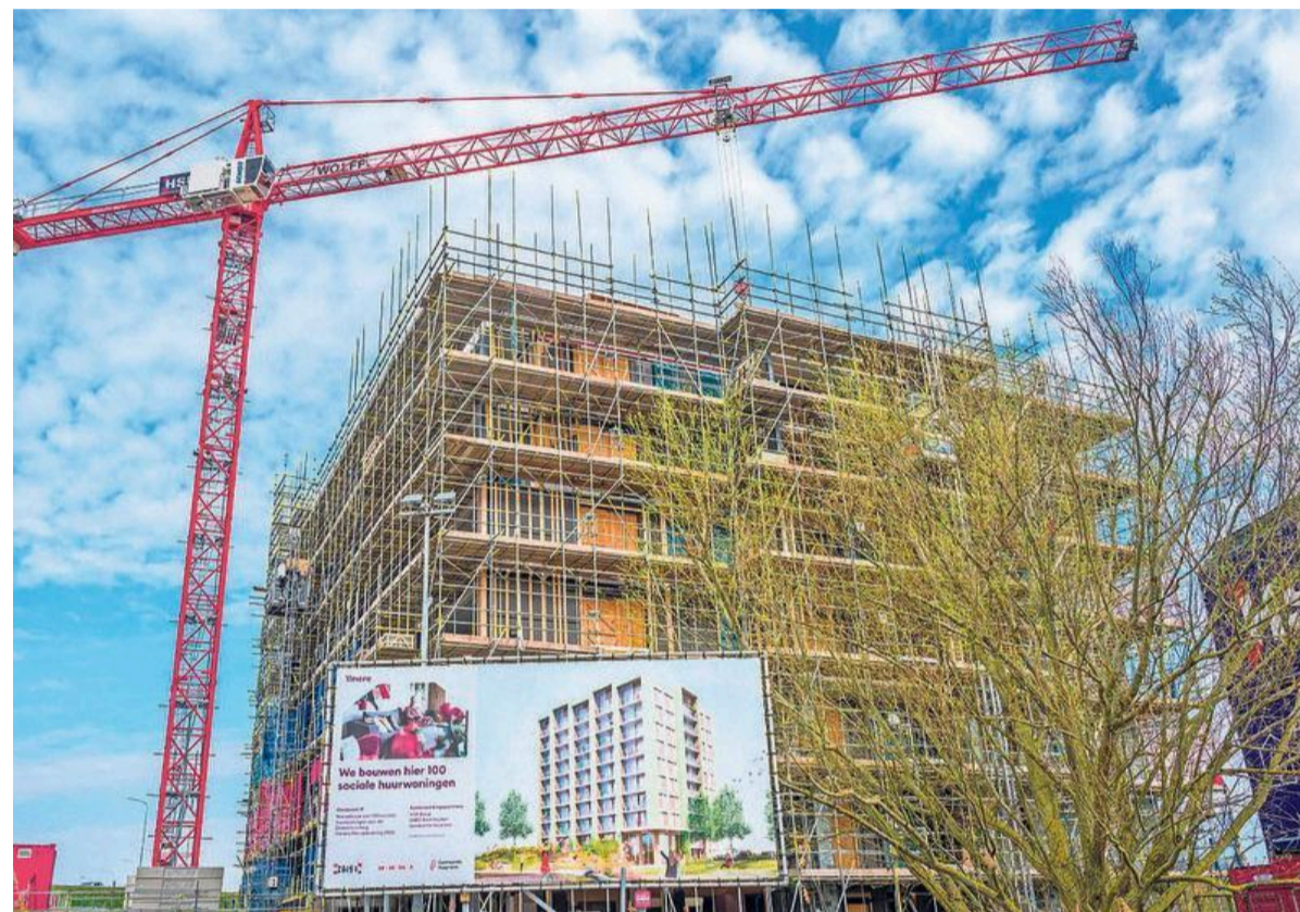
Zes van de tien verdiepingen staan inmiddels op elkaar.
