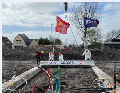
5 april Officiële handeling start bouw Groots in Heiloo
