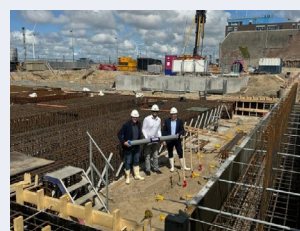
11 juli Feestelijke start bouw Dok 1 en Dok 11 Oud Ijmuiden
