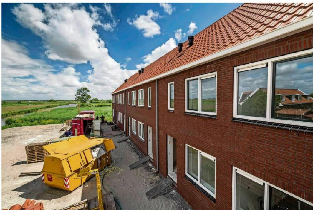
Deze acht sociale huurwoningen worden waarschijnlijk in september opgeleverd.
